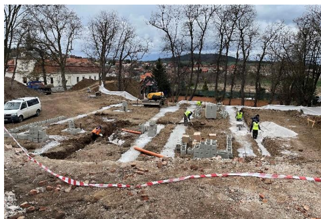
Základy pro budovu nahrazující původní sýpku
